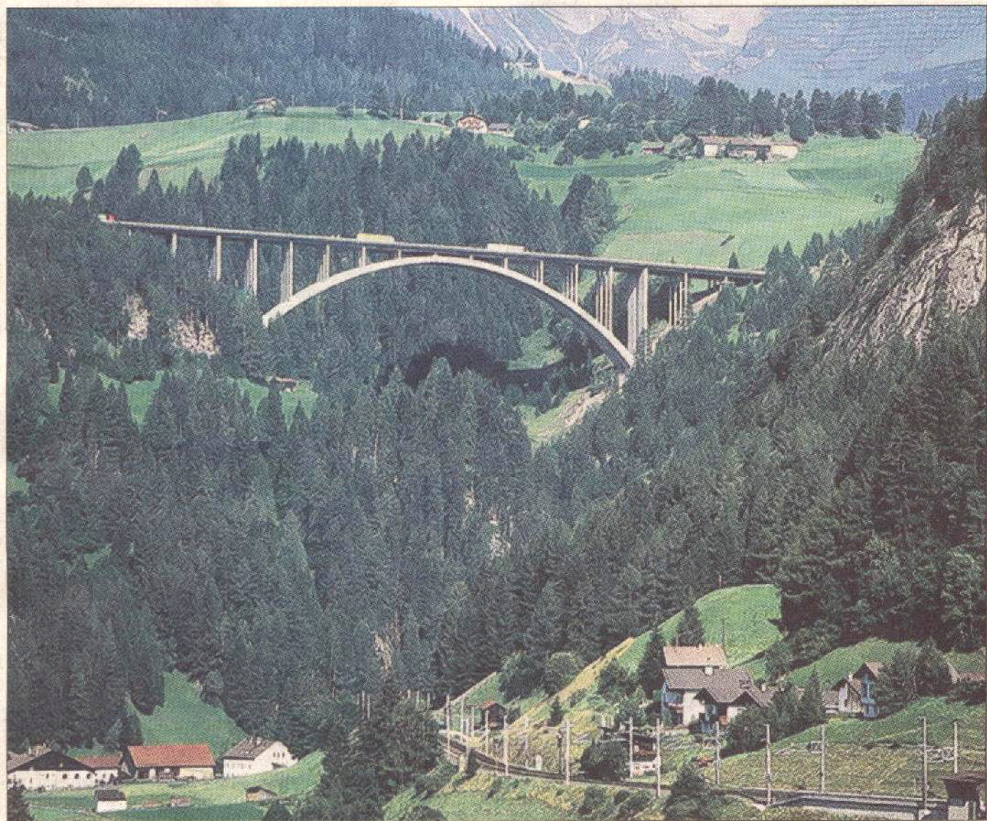
Oben quälen sich die Lkw den Berg hinauf, unten schlängelt sich die Bahnlinie durch die Täler: Die Brennerroute ist eine der meistbelasteten Transitstrecken über die Alpen. Für die nächsten Jahre wird eine deutliche Zunahme der Lkw-Zahlen vorhergesagt. Das Projekt „AlpFRail“ unter Federführung des Priener LKZ hat die Verlagerung des Güterverkehrs auf die Schiene zum Ziel. Foto: LKZ
